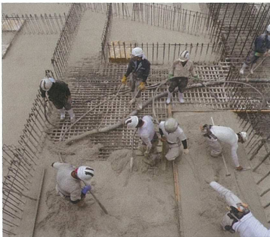
図-5 ECMコンクリートの適用状況
