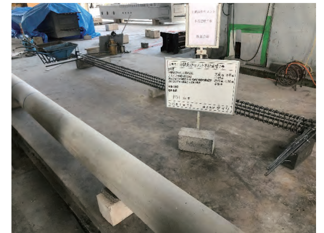
写真8 高強度ECMプレキャスト柱作製状況
