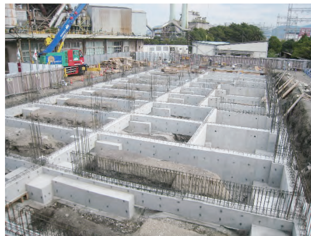
写真6 基礎および地中梁
