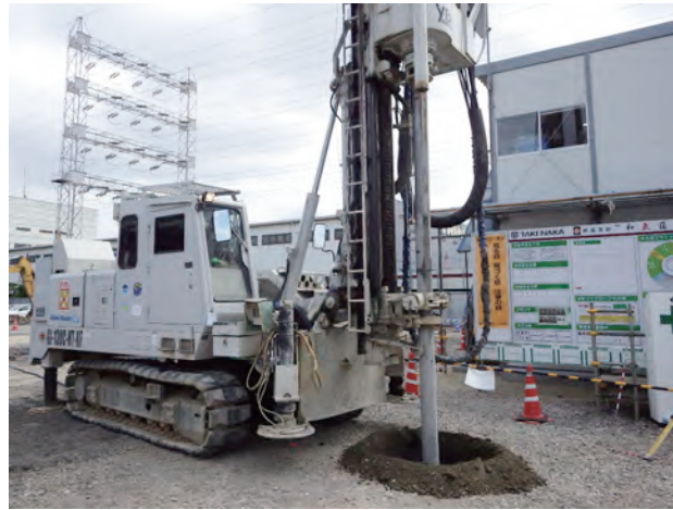
写真3 ECMソイル施工状況
