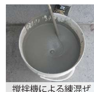
攪拌機による練混ぜ
