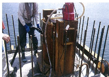
栈橋橋脚補強工事 (水中充填)
