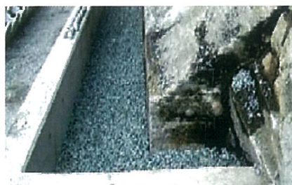
プレパクト工事
