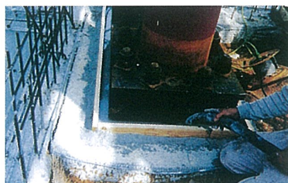
工場鉄骨基礎のグラウト
