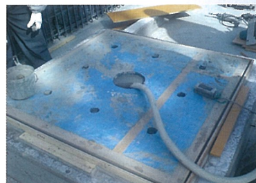
免振構造グラウト (ベースプレート下部充填)
