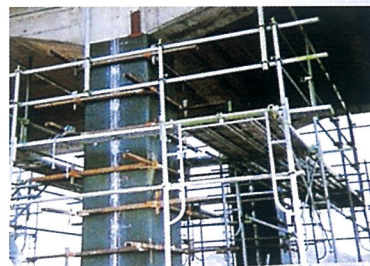
地下鉄高架橋耐震補強工事
