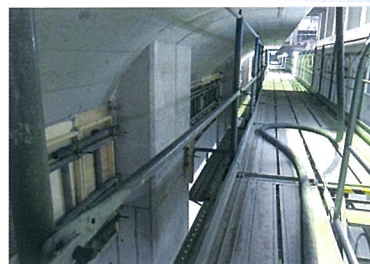
下水処理施設耐震補強グラウト
