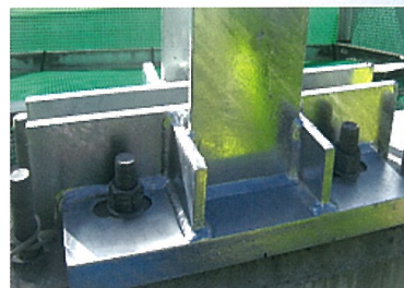
遮音壁基礎グラウト
