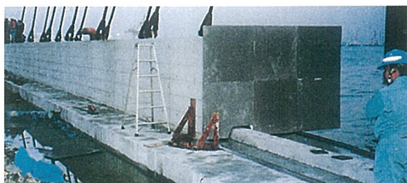
岸壁補修におけるプレキャスト部材のすき間充填
