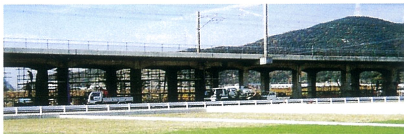
鉄道高架橋耐震補強工事
