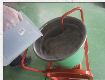
ミキサを回転しながら、練混ぜ水を徐々に投入して下さい。
