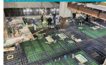
1 2 地下3階スラブの打設状況。高炉スラグを高含有したコンクリートは粘性が強く、比較的早くに流動性を失うが、「ECMコンクリート<sup>※2</sup>」は専用の混和剤と同時に開発し、流動保持性を高めている。作業性は普通セメントを用いたものと同変わらない 3 スラブでは表面仕上げが必要になるが、その作業性にも問題はなかった 4 仕上がりは普通セメントを用いたものに比べ白っぽい。それを意匠面で生かすことも考えられる
